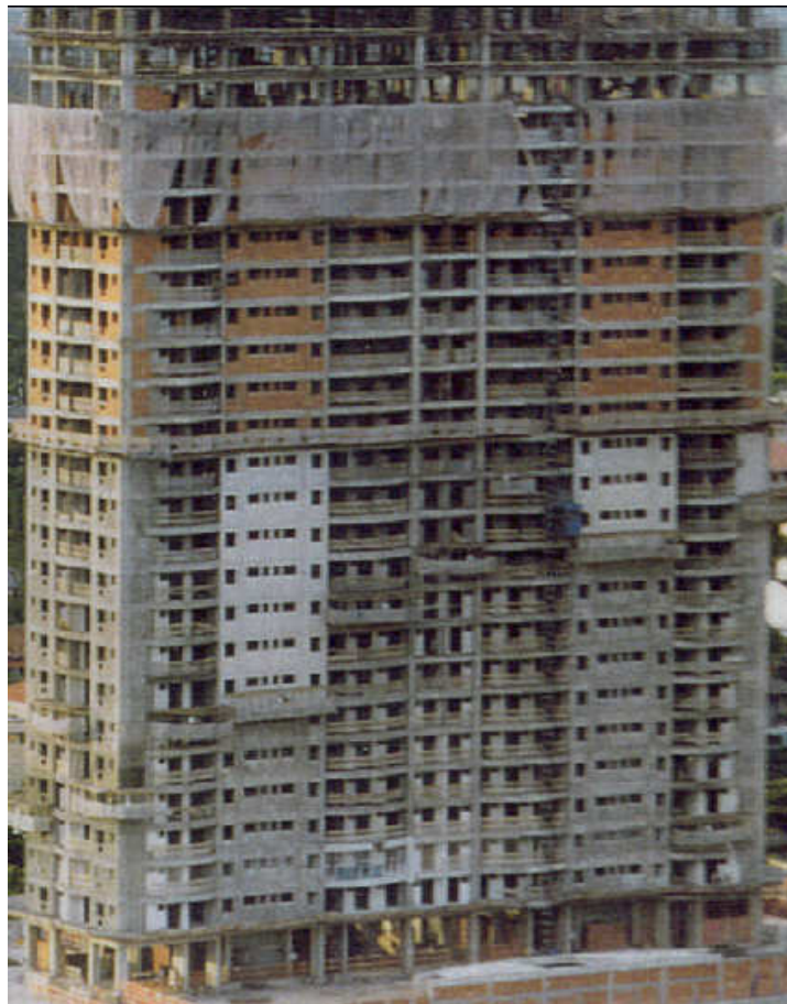
Fig. 03 Edifício com plataformas primária e secundária iniciando a colocação de tela de proteção.
