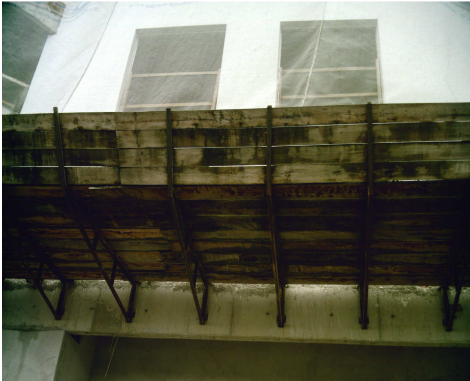
Fig. 02 Peças metálicas fixadas à estrutura do prédio para construção da plataforma de segurança (apara-lixo).
